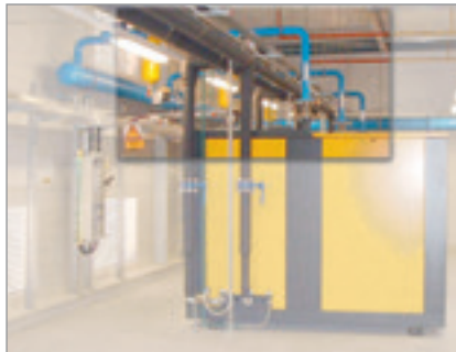
Figura 3b: Conexión flexible del compresor por medio de un compensador axial
